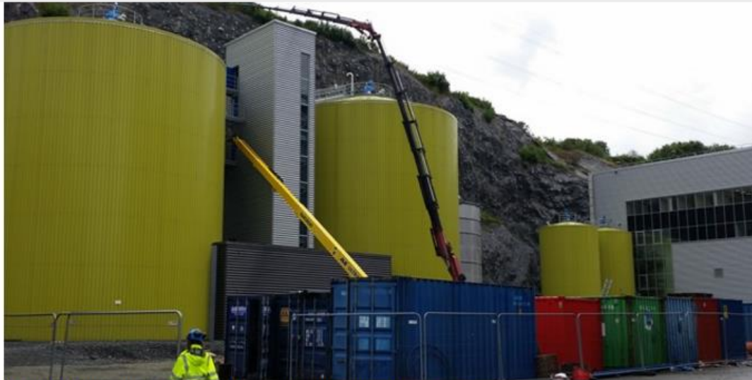
Det nye biogassanlegget i Rådal i Bergen. Foto: Bergen kommune
